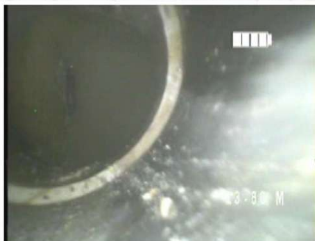
13.8公尺連接彎管接近E點汗水匯流管
